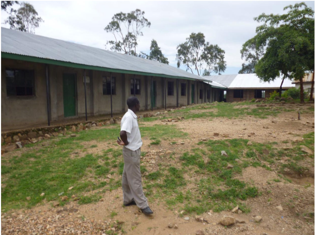
Dit is de volledige nieuwe school van Ombugo PS, Acht nieuwe klassen. Twee moeten nog wel afgewerkt worden (achteraan) maar de kinderen zijn allemaal al verhuisd naar de nieuwe school.
